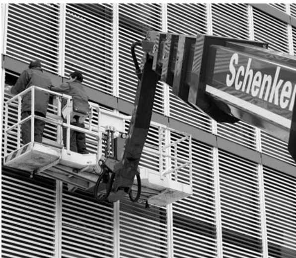
Skyworker der Schenker Storen AG
